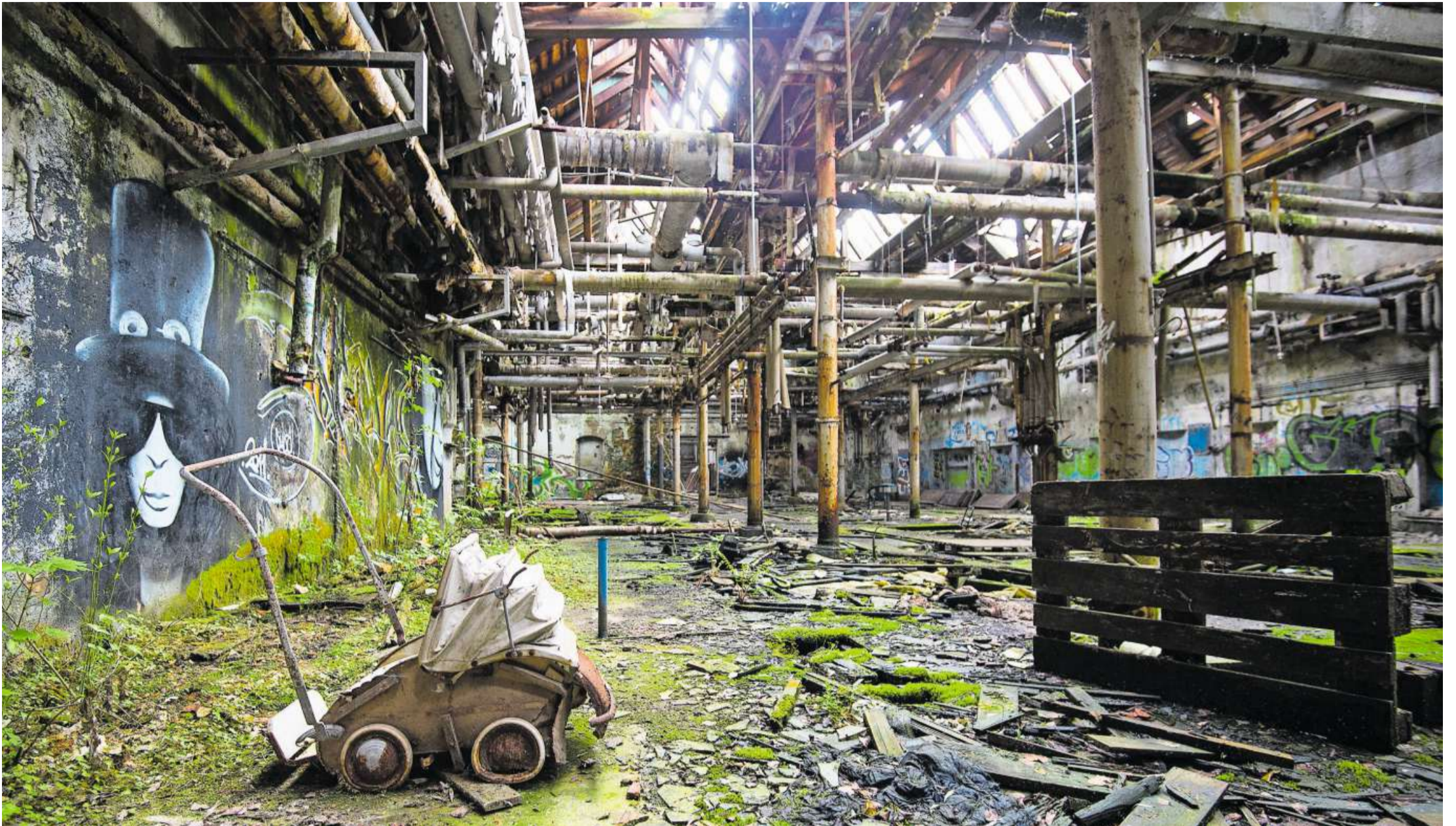
Bis in eine Tiefe von 15 Metern ist der Boden verschmutzt: Auf dem Raduner Areal in Horn, wo die Textilfabrik Raduner & Co. AG während über 100 Jahren produzierte, gelangten ab den 1950er-Jahren vor allem chlorierte Kohlenwasserstoffe in den Untergrund. Nach der Stilllegung der Textilfabrik 1989 mussten die Altlasten aufwendig und kostspielig saniert werden. Bild: Urs Bucher (Horn, 22.04.2014)
