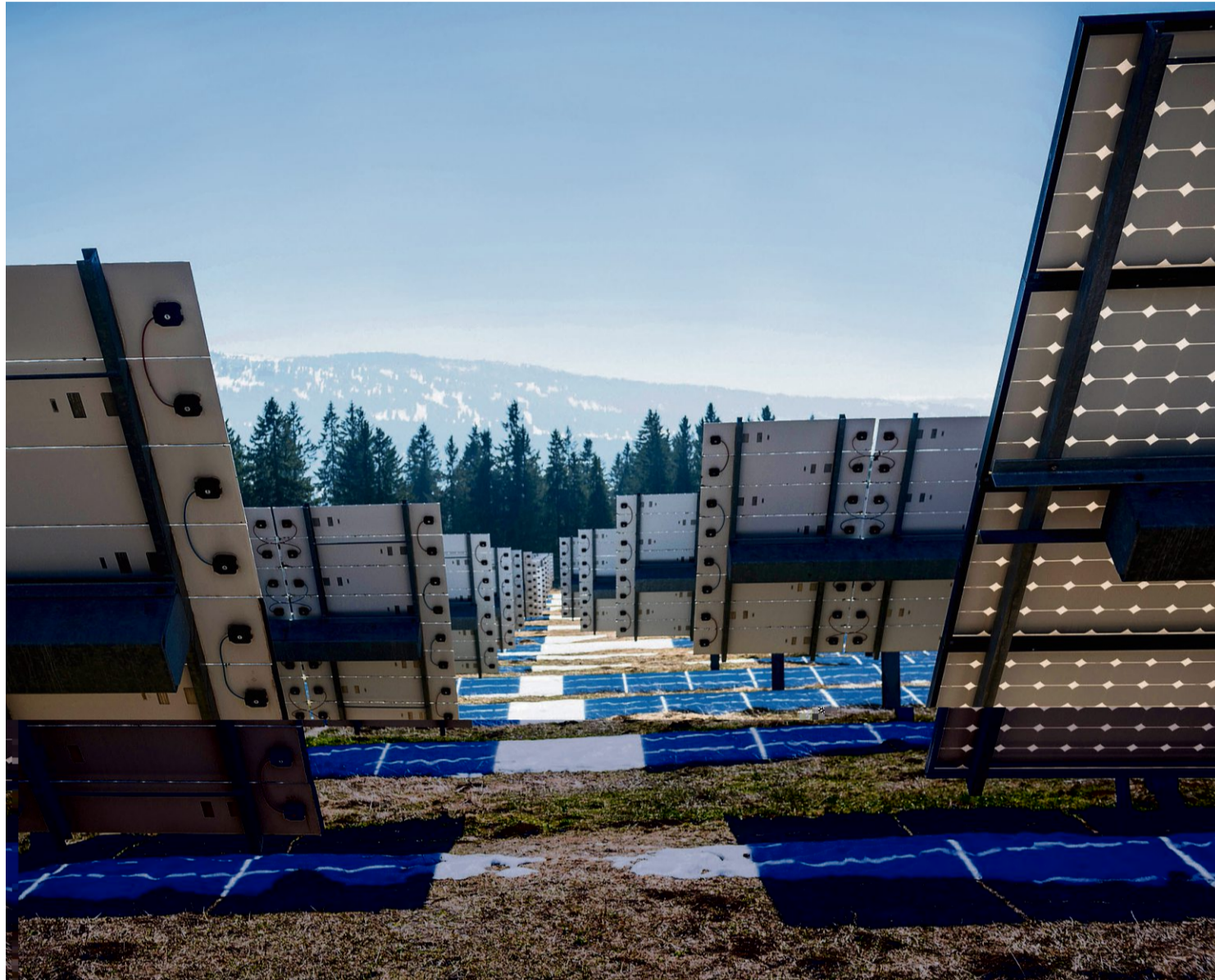
Effizienter als ihr Ruf und geeignet, die Stauseereserven zu schonen: Solaranlagen, hier auf dem Mont Soleil im Kanton Bern. Foto: Raisa Durandi
