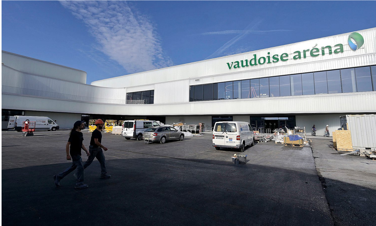
Le complexe sportif de la Vaudoise aréna, à Malley, à la fin des travaux de la patinoire en septembre 2019. CHRISTIAN BRUN
