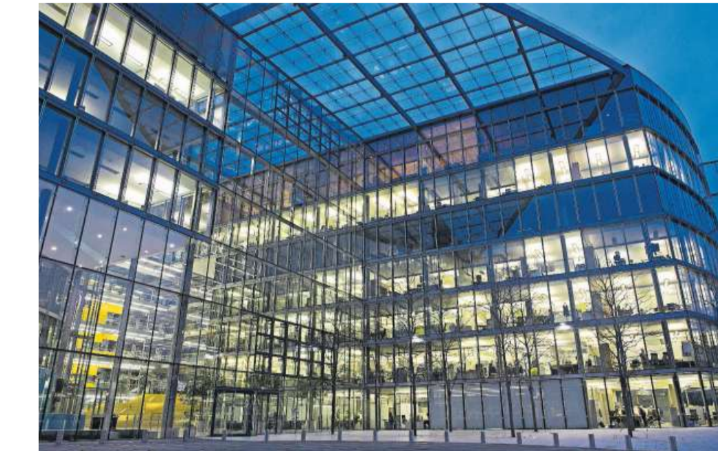
Nur die Fassade ist transparent: Der Campus Biotech in Genf.
