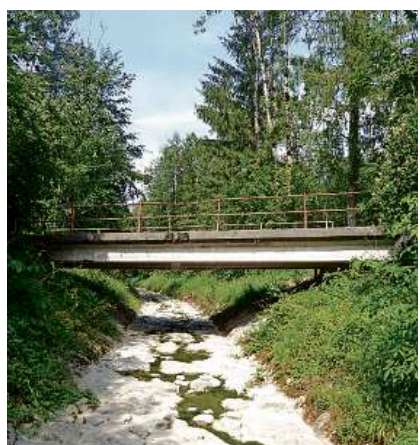
In die Jahre gekommen: Die Brücke über den Rufibach in Schänis wird demnächst ersetzt. Bild: Linthebene-Melioration
