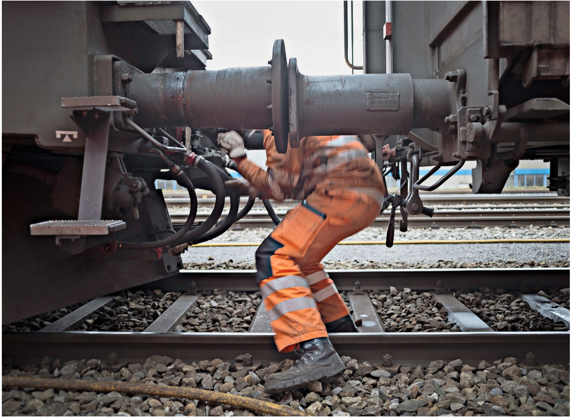
Handarbeit: Arbeiter im Rangierbahnhof Limmattal Foto: Michele Limina
