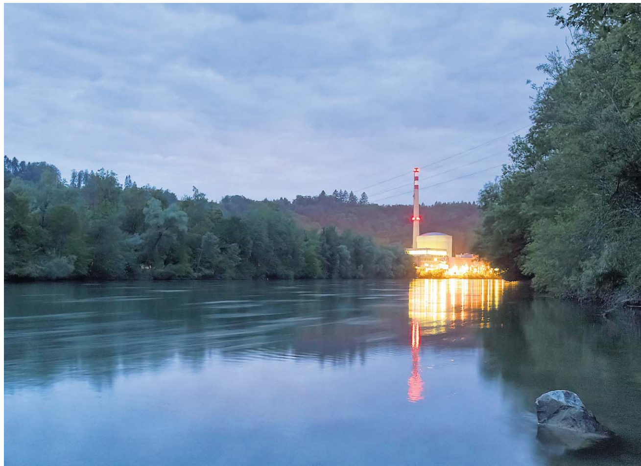
Beim AKW Mühleberg variiert die Erdbebenfestigkeit der Abschaltfunktion je nach Berechnung um 60 Prozent.
