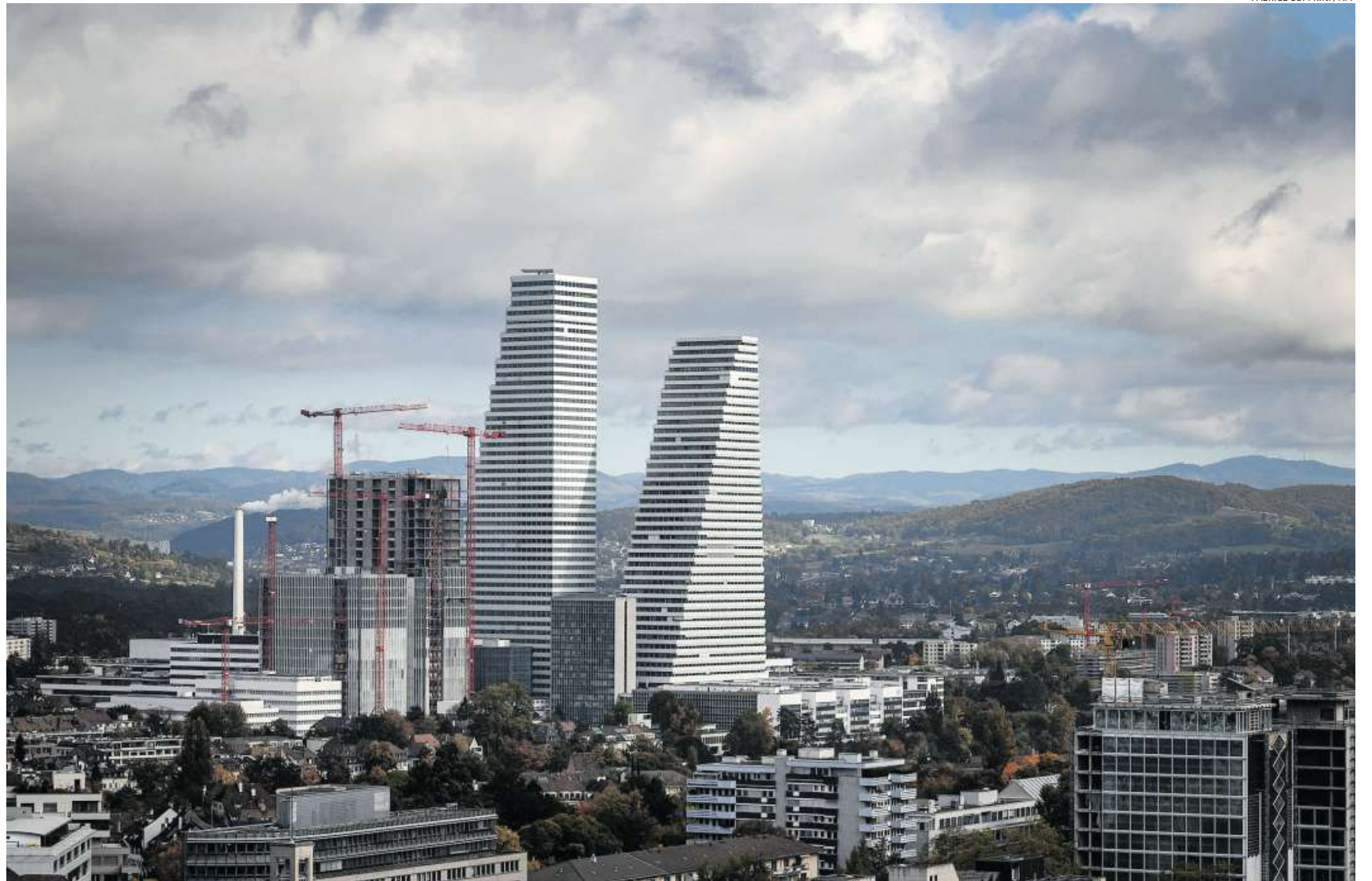
Die Roche-Tower in Basel: Die Pharmaindustrie tritt gegenüber dem Staat selbstbewusst auf. (Basel, 22. Oktober 2021)
