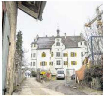
Renovationsarbeiten am Schloss Sonnenberg.
